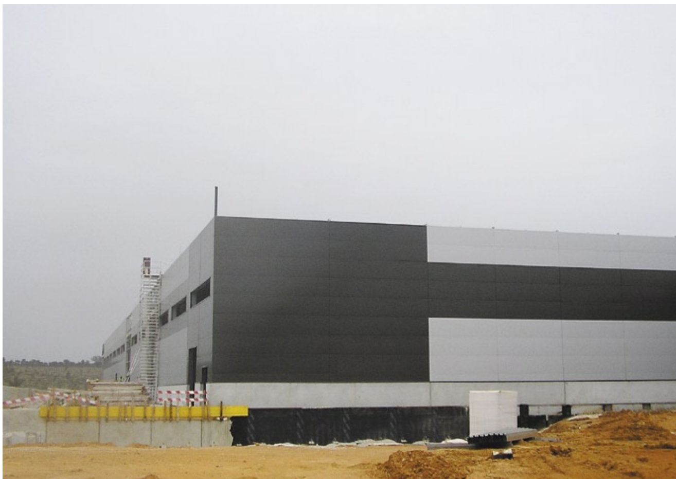
Los trabajos en los 28.000 m2 que ocupan la planta de producción de módulos y células se encuentran muy avanzados. Centrotherm proveerá la maquinaria.
