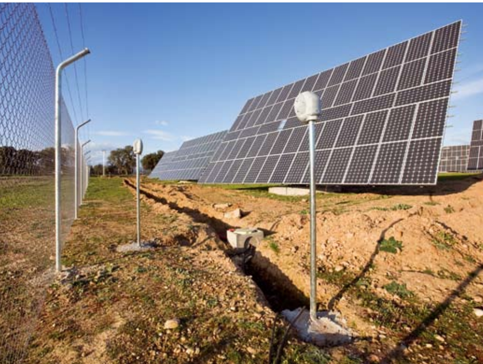
Hay detectores de movimiento instalados por todo el recinto. Si una persona no autorizada penetra en él, salta la alarma...
