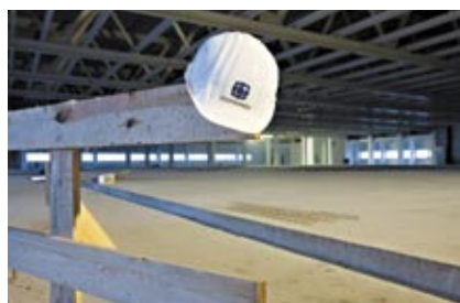
En construcción: la fábrica Conergy de Francfort del Oder.
